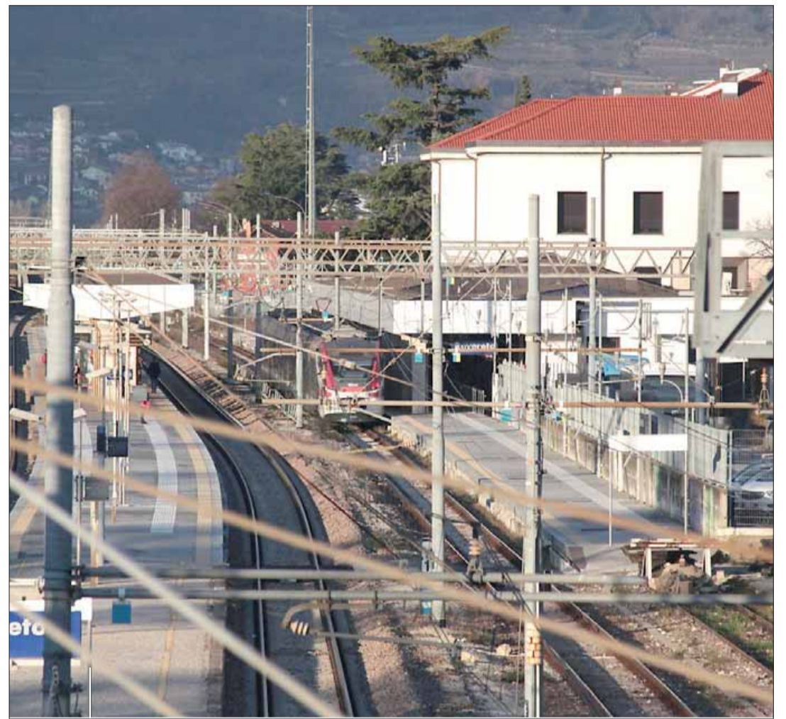
La stazione ferroviaria di Rovereto. L'interramento della ferrovia sotto la linea attuale sembra l'ipotesi più praticabile ma sono ancora molti i nodi da sciogliere, dalla curvatura all'impatto idrogeologico, al collegamento con altri rami ferroviari come l'ipotizzata linea Rovereto-Riva, alla metropolitana di superficie
