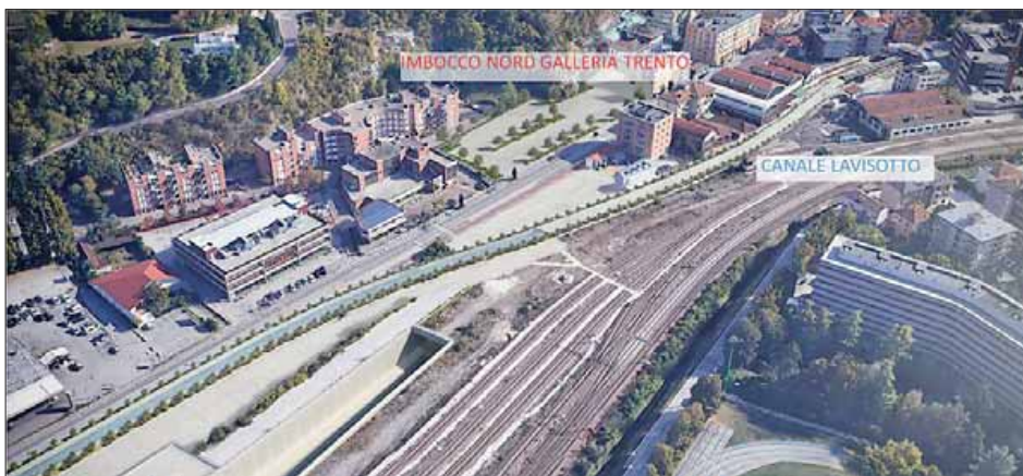
La zona dello Scalo Filzi dove è previsto l'imbocco nord e verranno abbattuti 11 edifici
