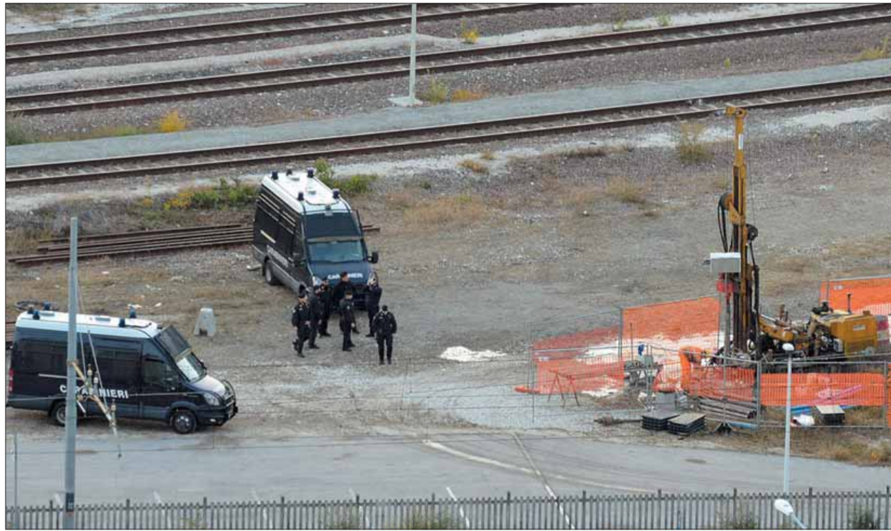
La trivella in azione sorvegliata a vista dalle forze dell'ordine
