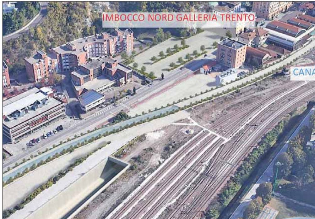
L'area a maggior impatto prevede l'abbattimento di dieci edifici tra via Brennero e via Malvasia
