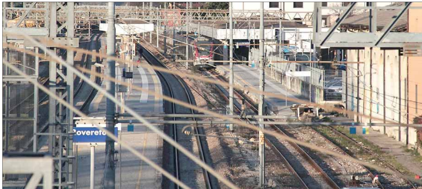
La ferrovia all'altezza della stazione dei treni. Una delle due opzioni progettuali di Rfi
