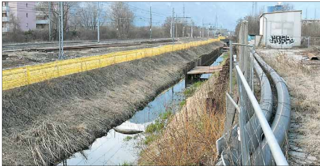
Le palancole e le attrezzature sistemate lungo il Lavisotto nel tratto da bonificare (fotografie Paolo Pedrotti)
