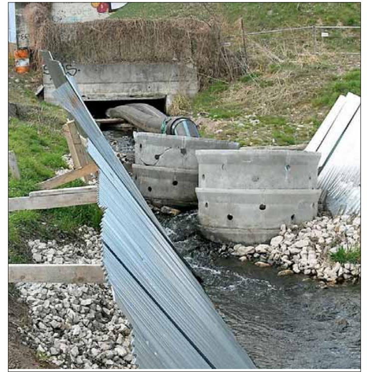
Così appare un altro tratto della roggia
