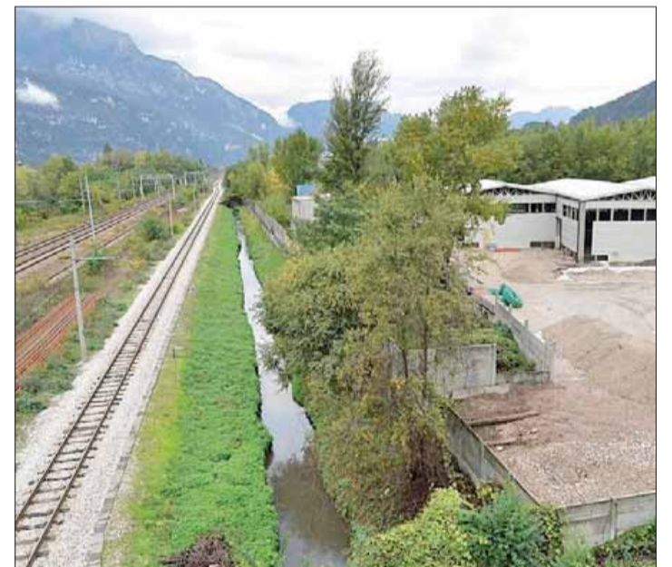
La ferrovia nel tratto in cui passa tra ex Sloi ed ex Carbochimica
