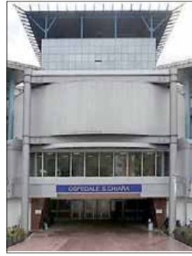
L'ingresso del Santa Chiara
