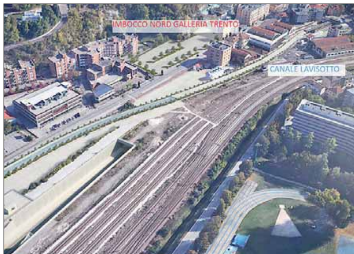
L'accesso nord alla galleria, nel progetto di bypass ferroviario
