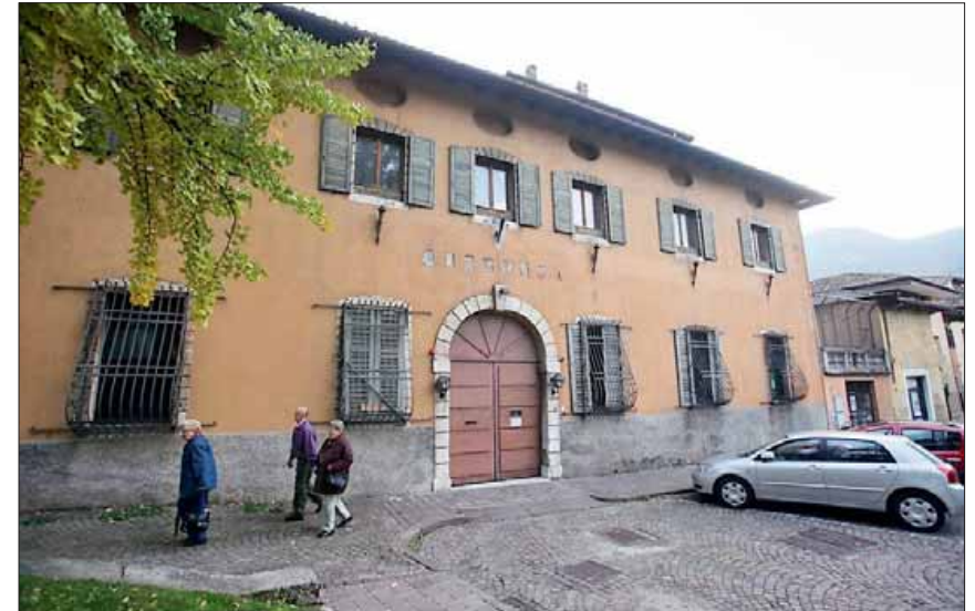
La vecchia sede della questura, edificio chiuso dal 2006, in piazza Mostra
