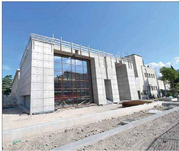
Il cantiere in corso all'interno del cimitero (foto Daniele Panato)
