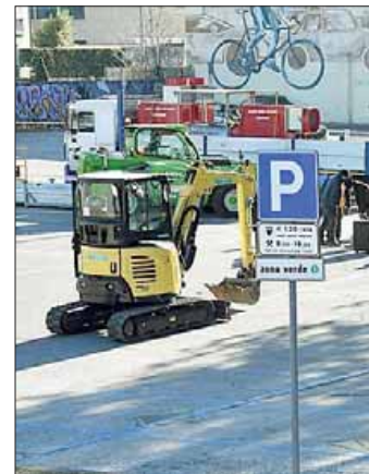
La bonifica del sottosuolo conclusa
