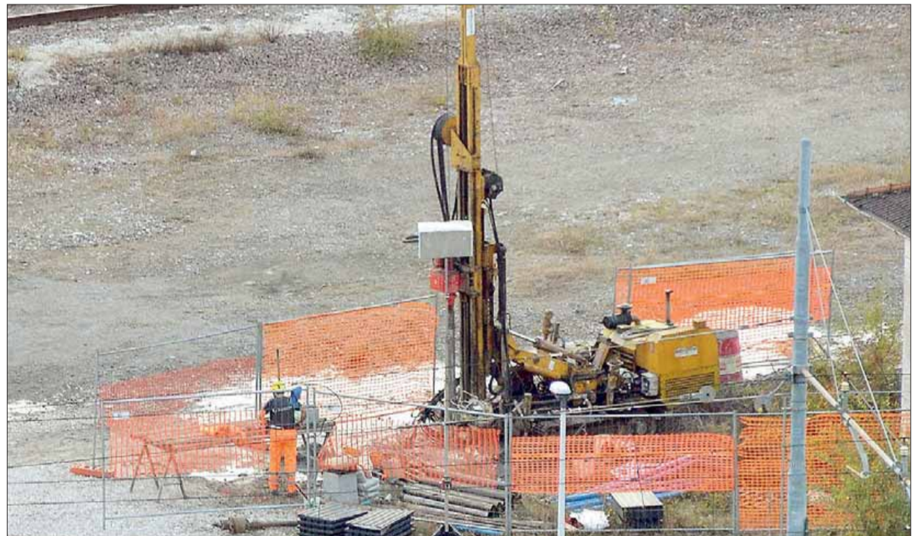
Finora in vista del bypass sono state effettuate trivellazioni di sondaggio, dall'anno prossimo coi lavori i cantieri veri e propri
