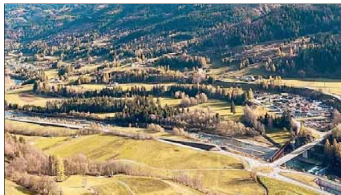
In basso, tra il bosco e la strada, la località Porina a Tesero
