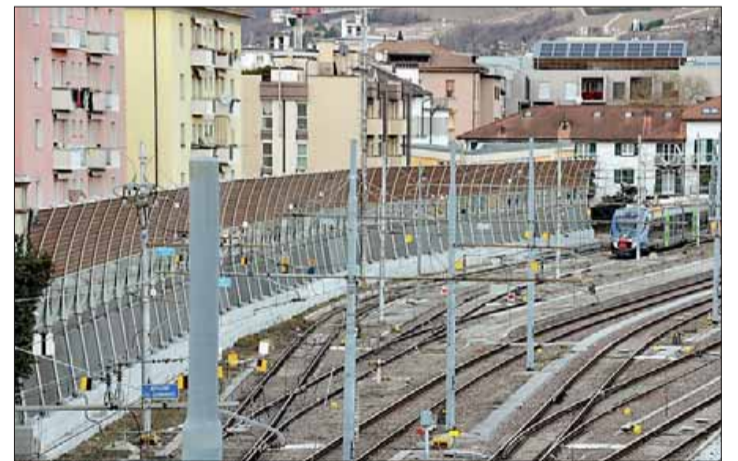
La barriera antirumore installata nell'area della stazione (foto Paolo Pedrotti)
