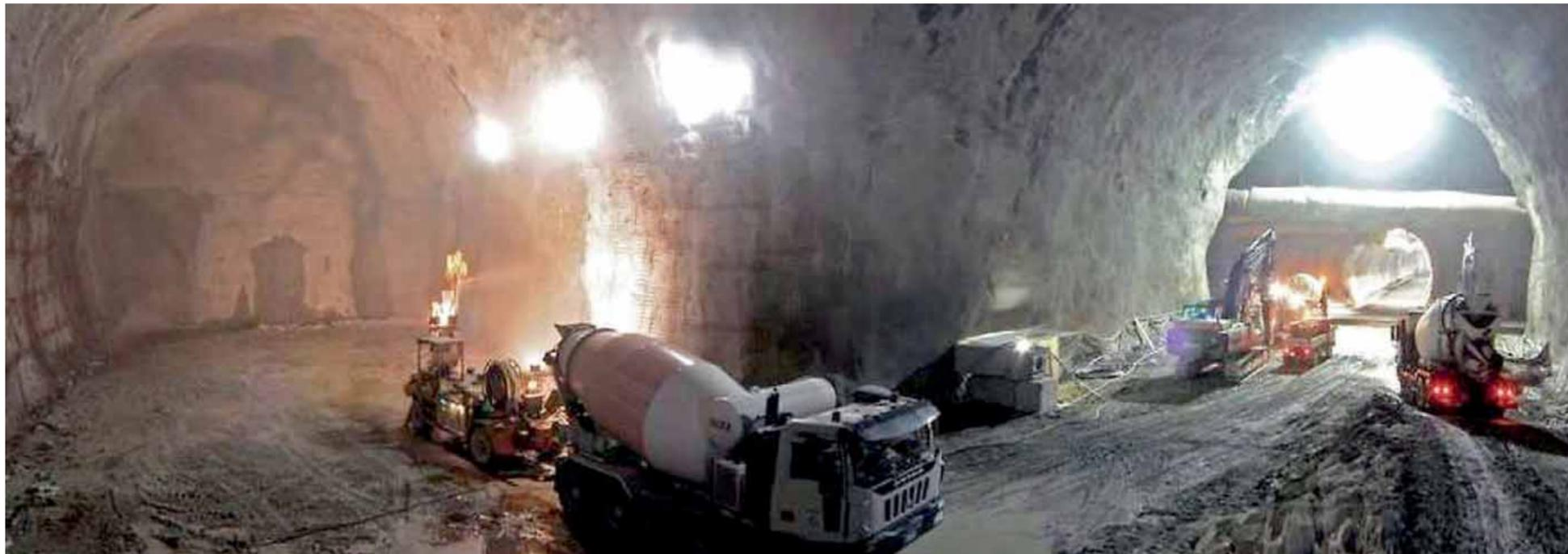
Lo scavo in galleria della galleria di base del Brennero - Brenne Base Tunnel: la tecnologia con mine e frese è la stessa che si applicherà a Trento, ma da noi sarà sotto case e paesi densamente abitati (QUESTA ED ALTRE FOTO BBT-ARCHIV)
