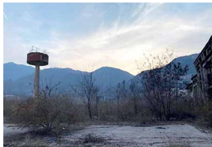
L'area della ex Sloi: 180 tonnellate di piombo nel terreno e nelle acque
