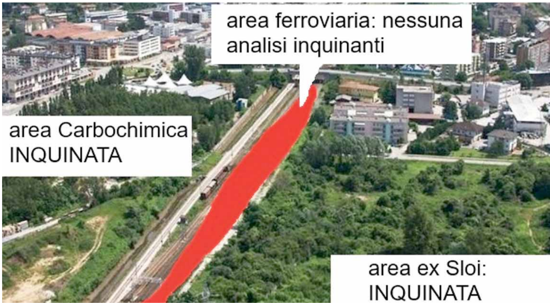
Il paradosso di Trento Nord: in mezzo a due aree talmente inquinate da essere «Sito di interesse nazionale», passa la ferrovia: qui Italferr intende scavare fino a 21 metri di profondità
