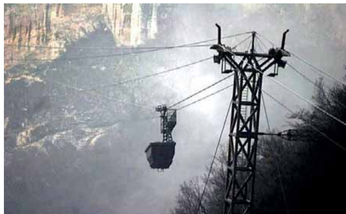
La teleferica da Maso Visintainer di Trento alla ex discarica di Sardagna
