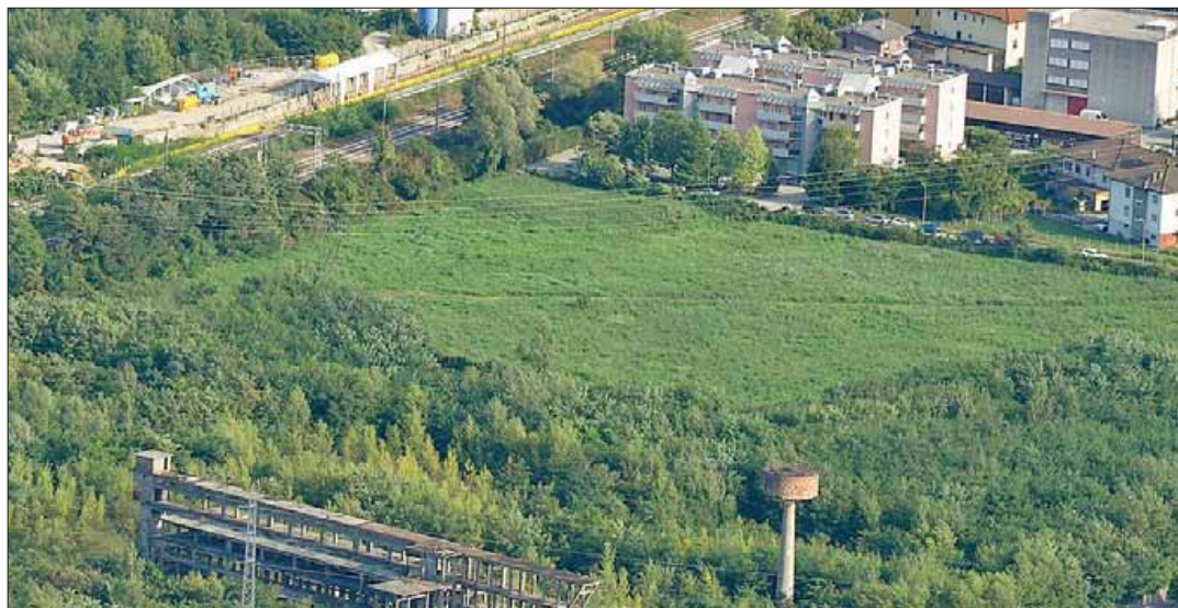
L'area ex Sloi: al via a marzo il monitoraggio sul Soil gas
