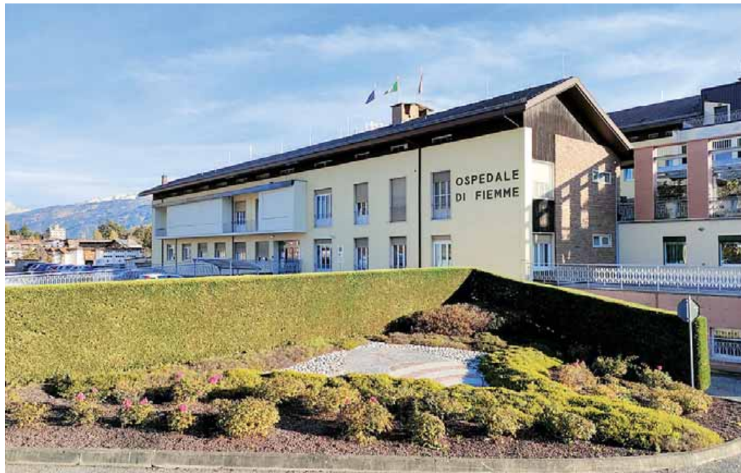
L'ospedale a Cavalese: da due anni al progetto di restauro si è affiancato il progetto di una nuova struttura a Masi
