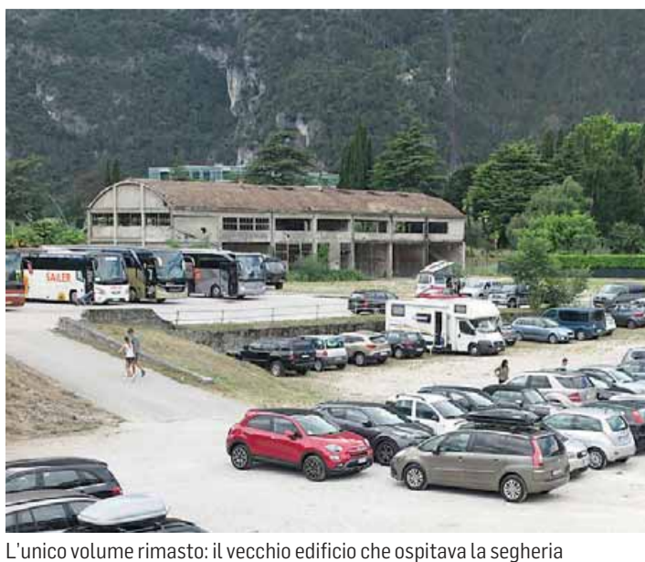
L'unico volume rimasto: il vecchio edificio che ospitava la segheria
