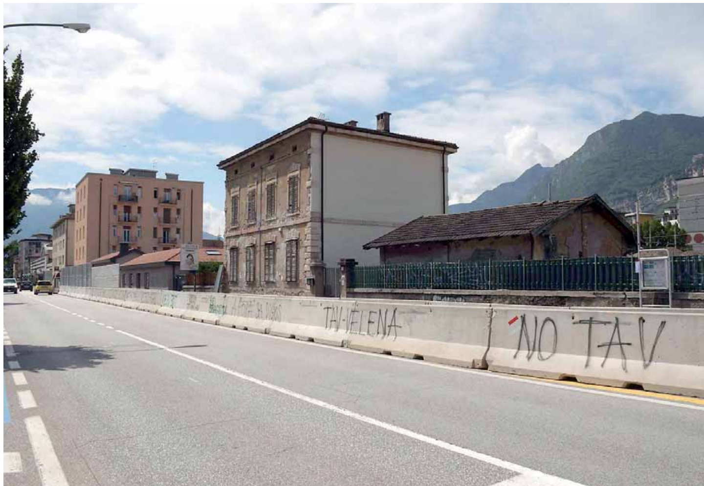
Via Brennero sta cambiando volto. Nell'immagine i jersey posizonati lungo l'area marciapiede (foto di Daniele Panato)
