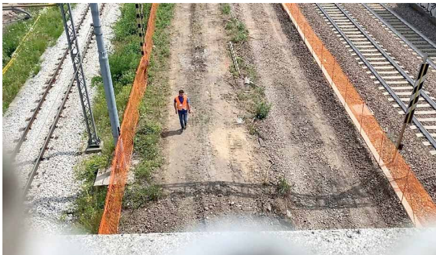
Il cantiere aperto nell'ex Scalo Filzi: sono le «opere preparatorie» per l'accesso al punto di scavo delle gallerie Nord di Trento
