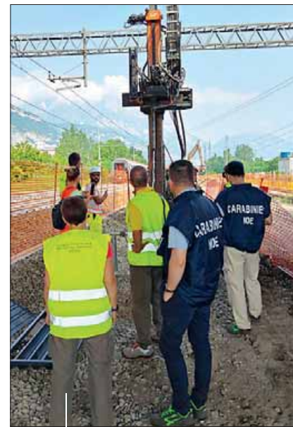
Sopra i carotaggi effettuati alla presenza dei Carabinieri del Noe. A sinistra la sezione di areale ferroviario sequestrata
