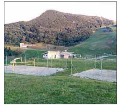
L'area della stazione di arrivo, a Vason
