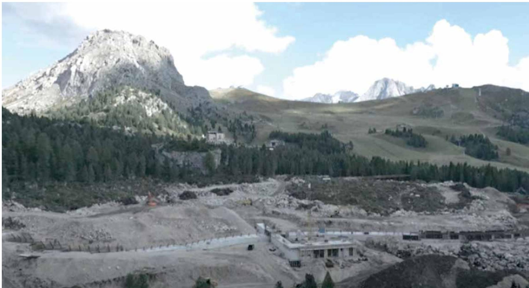
L'imponente muro di contenimento, alto quindici metri e lungo cinquanta, con il «cratere» del grande bacino di innevamento sotto il Belvedere
