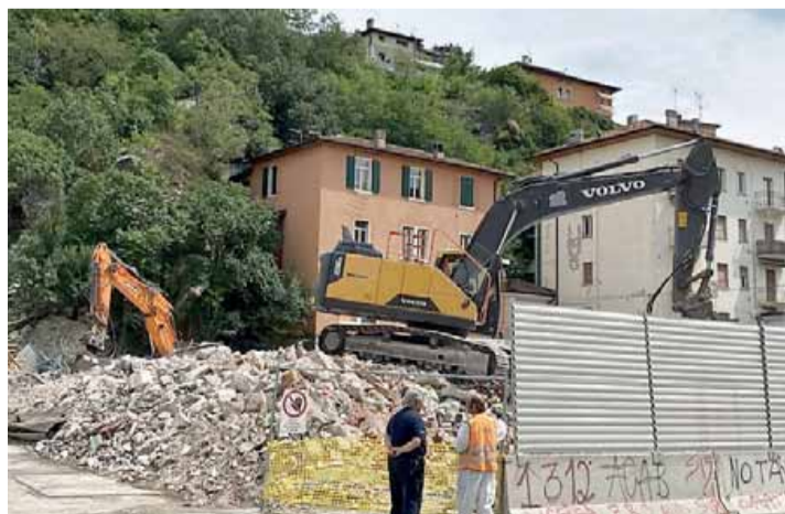
Intanto, in via Brennero, giù il primo edificio sul lato est
