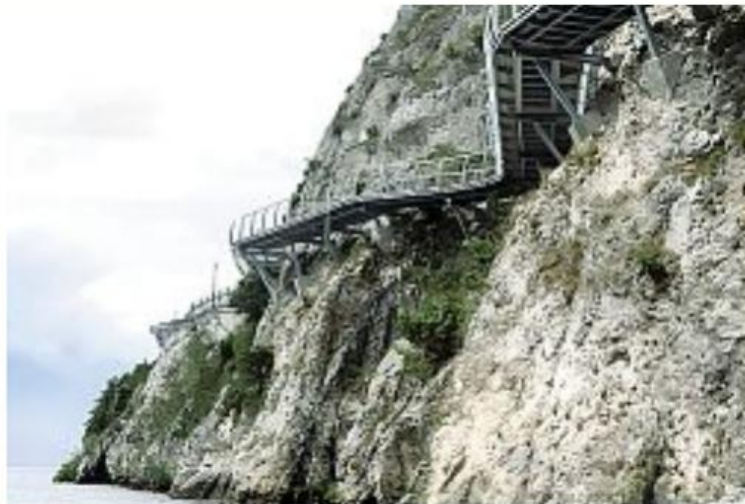
A sbalzo Alcune immagini dei tratti di passerella affacciati sul lago
