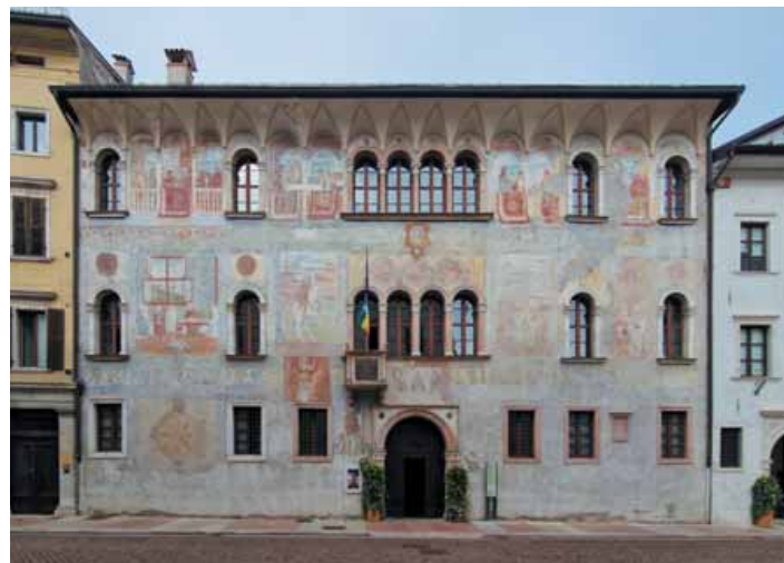
La facciata di Palazzo Geremia, in via Belenzani
