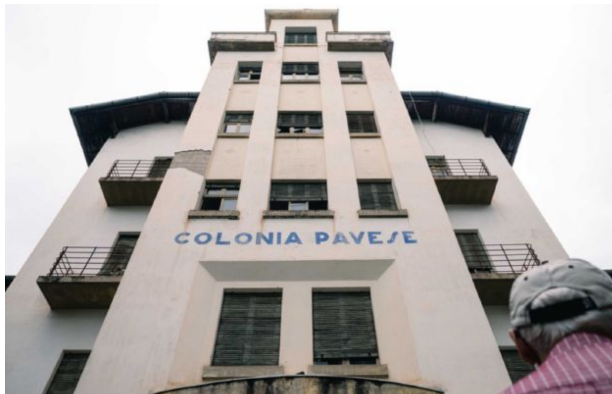
L'edificio La colonia pavese di Daiano è stata realizzata nel 1933 e abbandonata nel 1976
