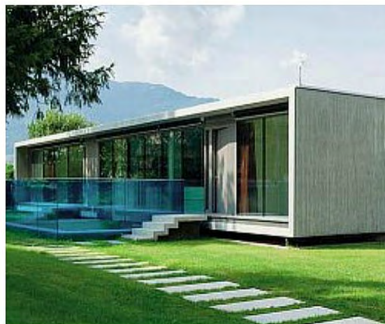
Martignano Ristrutturazione Casa B, piazza Meneghin
