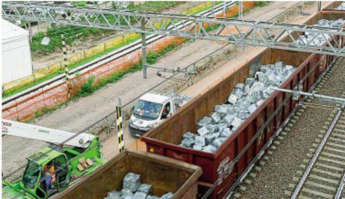
Il cantiere L'area posta sotto sequestro interessata dalle indagini ambientali. Nel tondo, il sindaco Ianeselli
