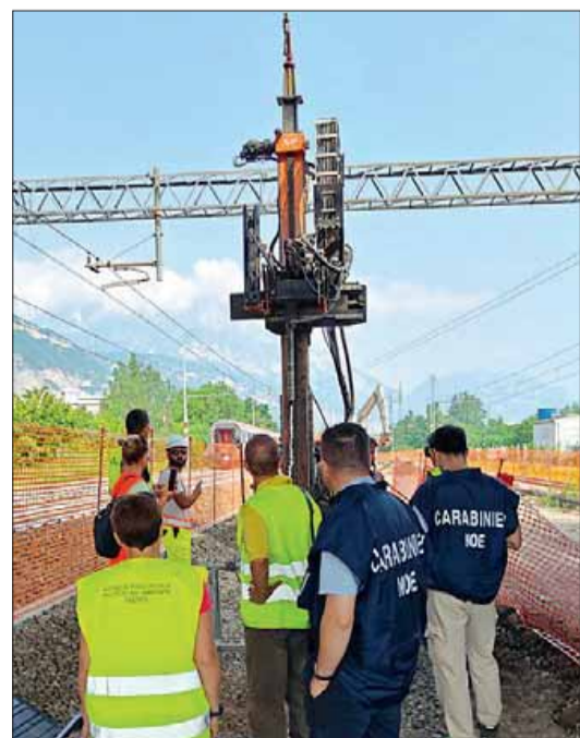
La trivella in azione per i carotaggi sotto i binari
