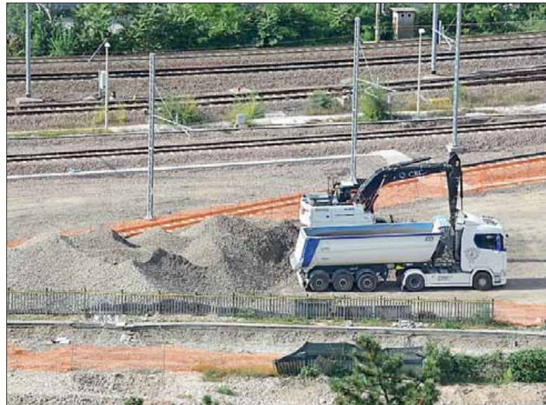
I lavori al cantiere nord per il bypass ferroviario: lo scalo Filzi
