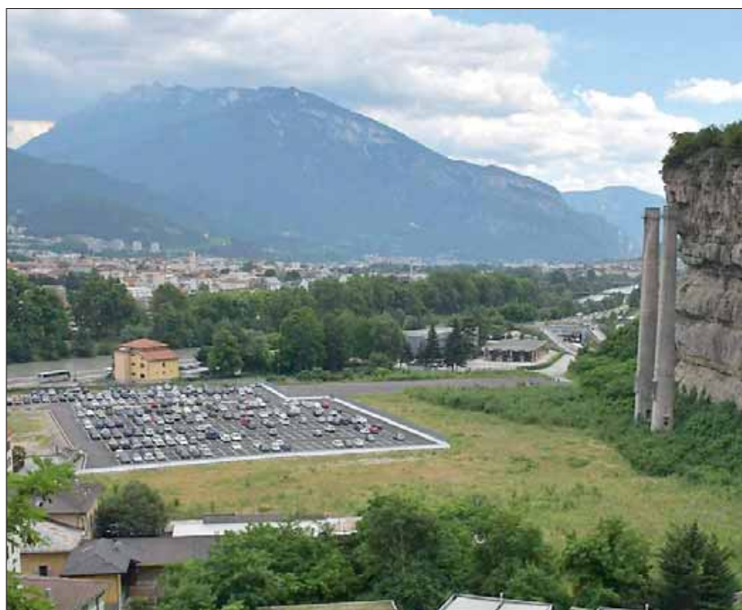
L'attuale parcheggio all'ex Italcementi con le due ciminiere da abbattere
