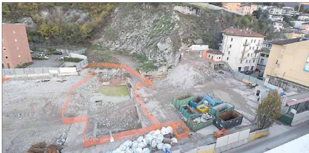
Il cantiere per il bypass ferroviario a Trento nord
