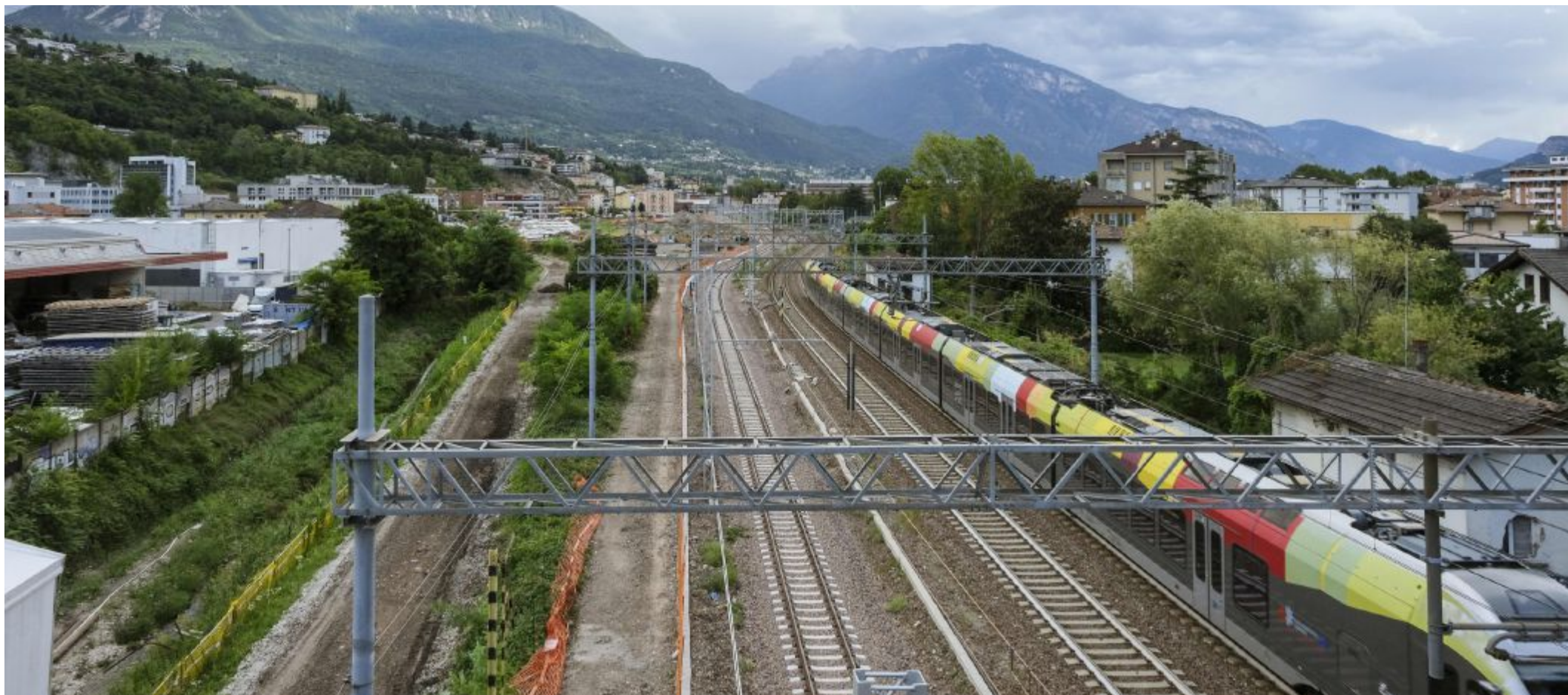
Circonvallazione di Trento La maxi opera viabilistica comporta anche la necessità di occupare alcune aree il tempo dei lavori, di qui la notifica, da parte di Italferr Spa, del decreto di occupazione temporanea
