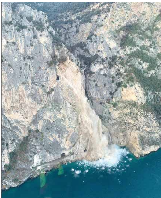
Una panoramica della terza scarica della frana scattata da un drone
