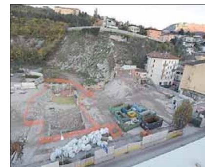
Il cantiere all'imbocco nord in S. Martino
