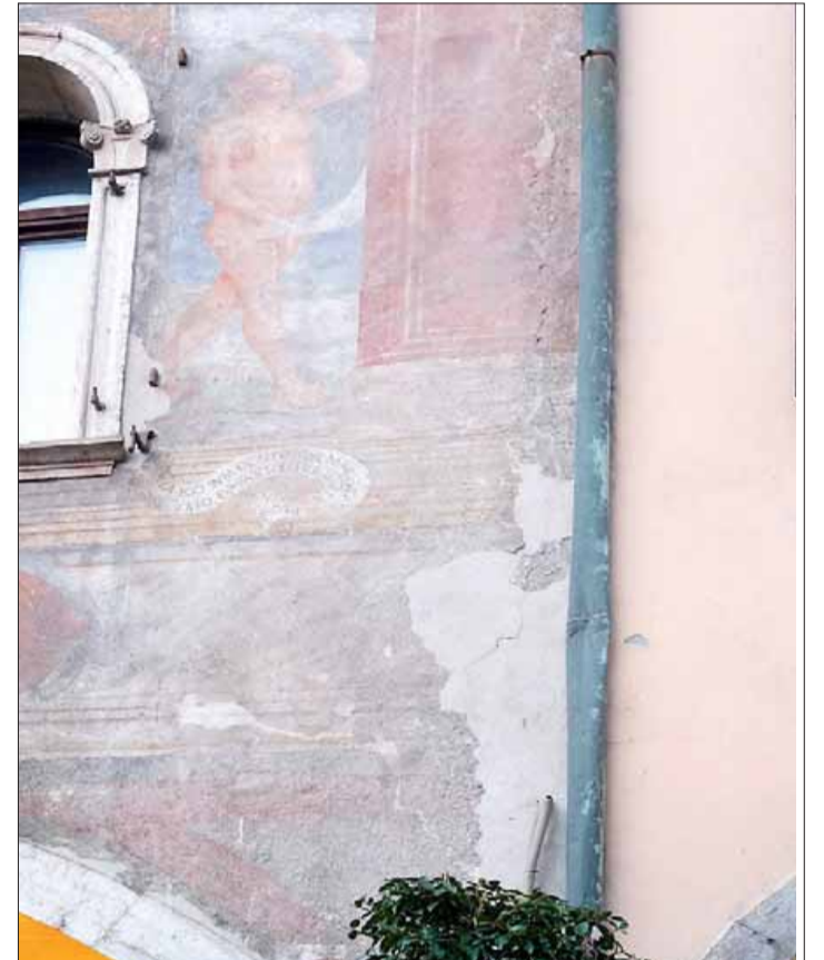
Una chiazza di malta ricopre l'area che era stata "bucata" per errore (A.Coser)
