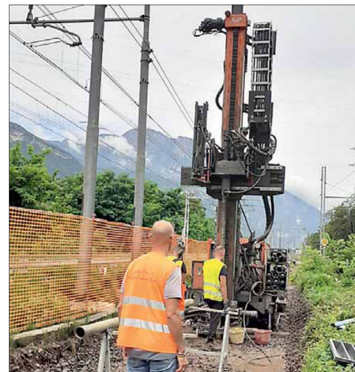
I carotaggi per analizzare il sottosuolo lungo i binari
