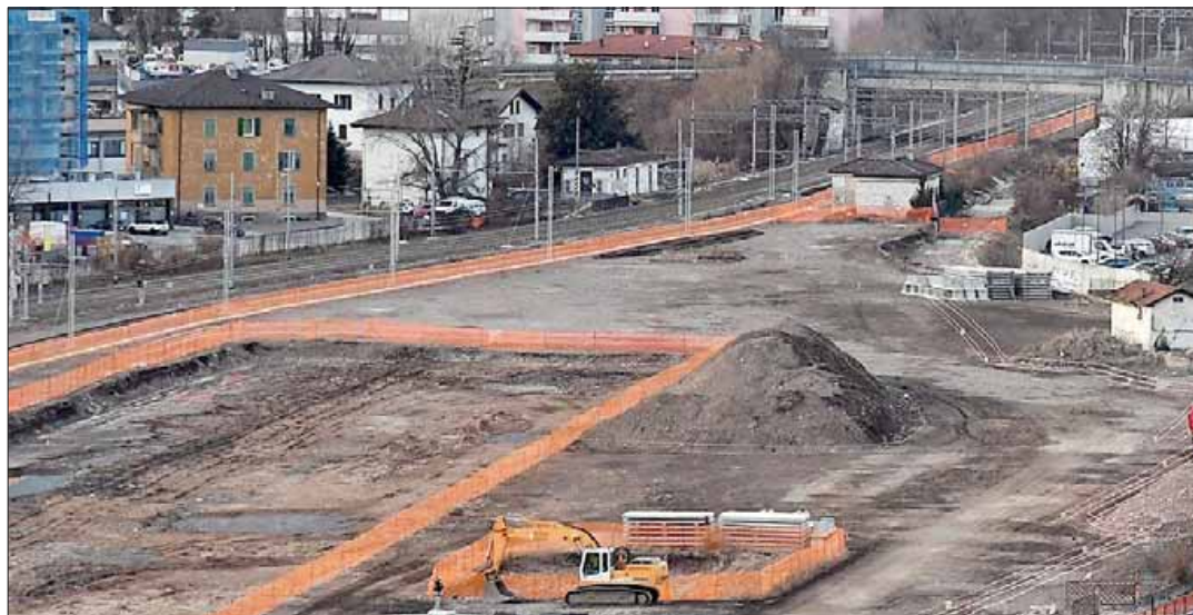
All'interno del cantiere allo Scalo Filzi da giorni tutto si è fermato (foto Paolo Pedrotti)
