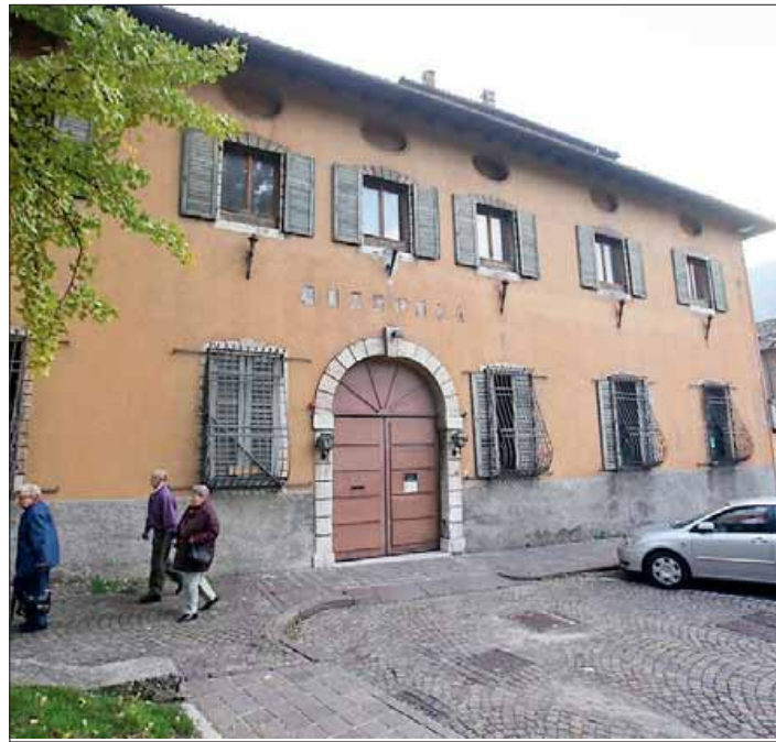
La sede della ex questura di piazza Mostra, edificio ormai degradato
