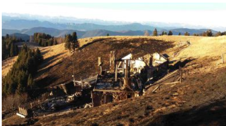
Distrutto I resti del Rifugio Tonini dopo l'incendio del 2016
