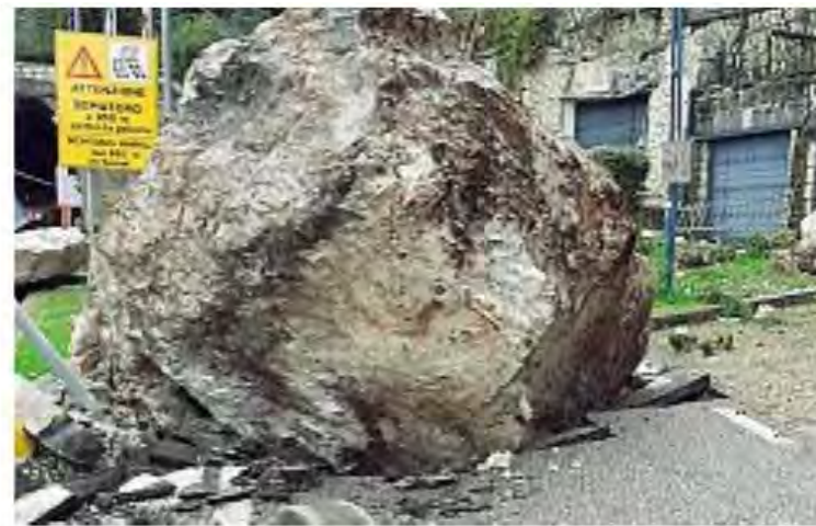
Lago di Garda La frana avvenuta lungo la statale che da Riva porta a Limone
