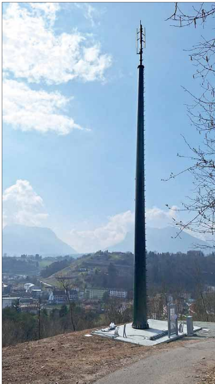
L'antenna alta quasi trenta metri svetta nei pressi del Maso al Pont
