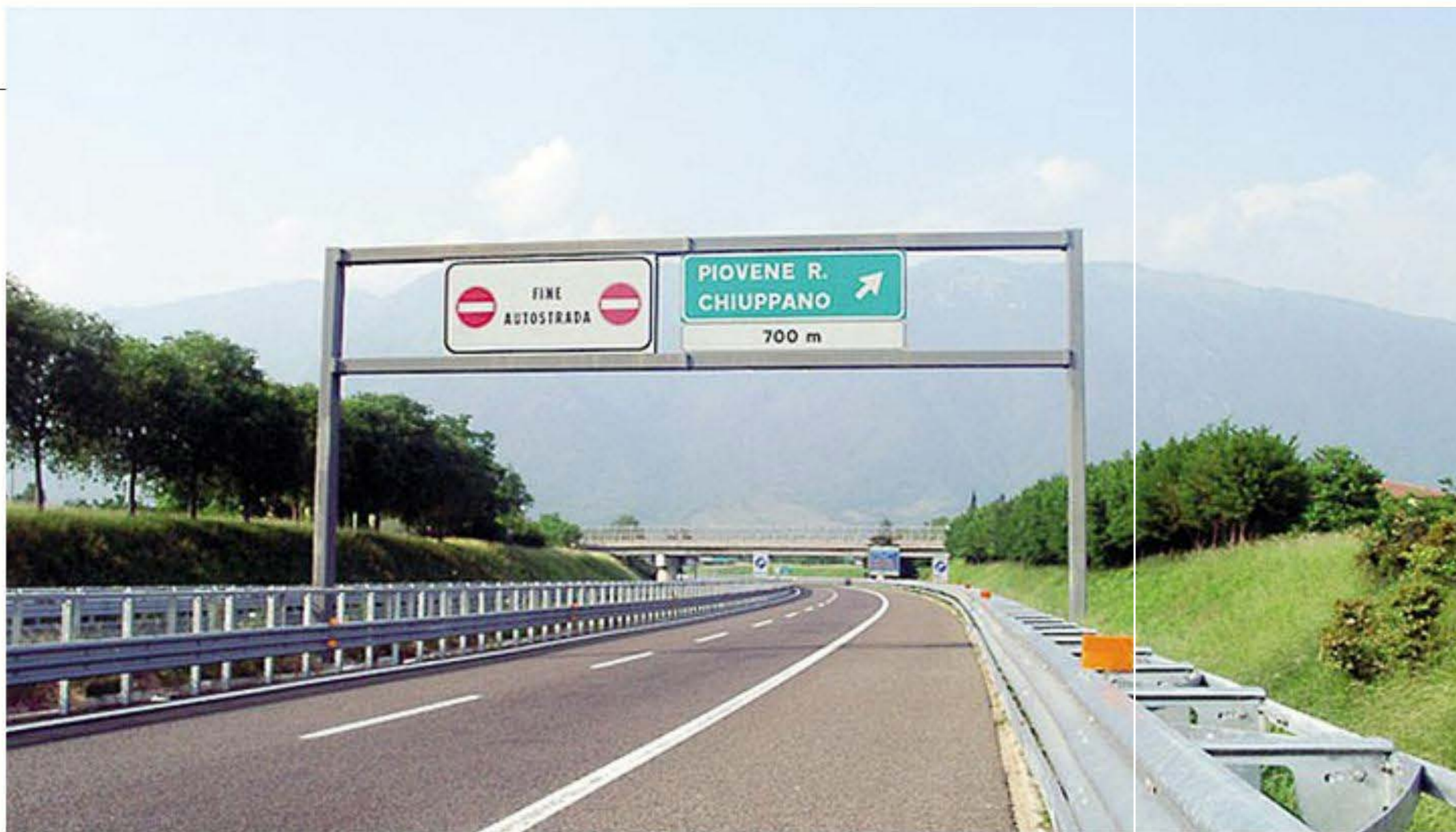
Interrotta La fine della Valdastico a Piovene Rocchette in Veneto: da lì dovrebbe partire il cantiere del prolungamento a nord verso il Trentino
