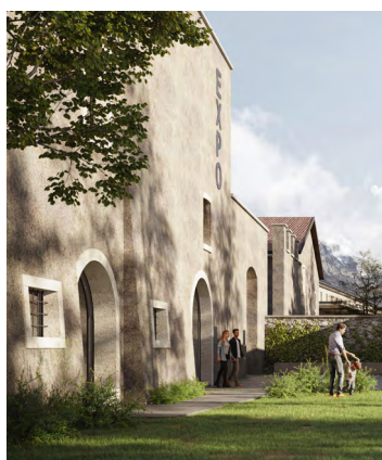
1 L'accesso da est (dall'esterno del recinto del Palazzo) al percorso espositivo e alla sala conferenze evidenzia la storica funzione delle barchesse
