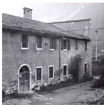
1 La Barchessa Sud prima del crollo del tetto e del distacco dell'intonaco
