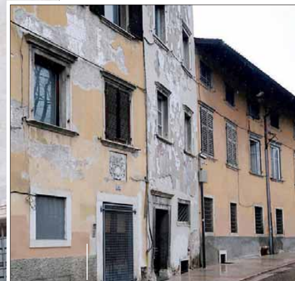
A sinistra Palazzo Geremia, nella foto sopra, l'ex palazzo della questura sul lato di via San Marco. Sono due degli edifici che Italia Nostra ha indicato tra le priorità per i restauri
