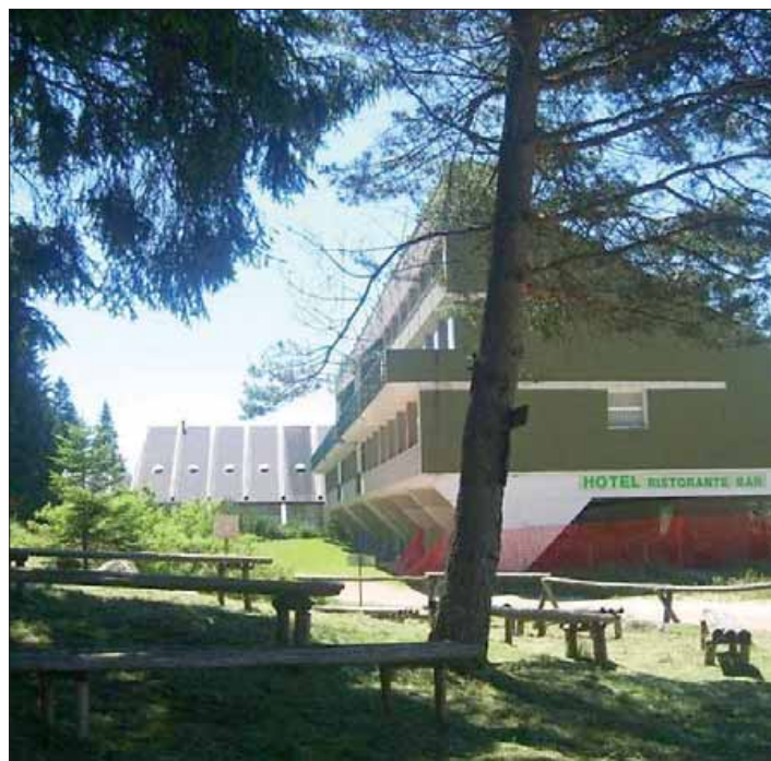
Sulla destra, la struttura vetusta che sarà abbattuta
