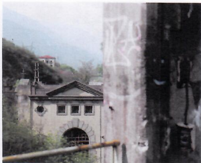
A sinistra: La centrale elettrica, lato sud, vista dal tetto della sala forni B; sullo sfondo, la villa del direttore.
