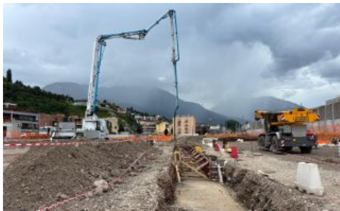
Cantiere Lavori in corso per il bypass ferroviario
